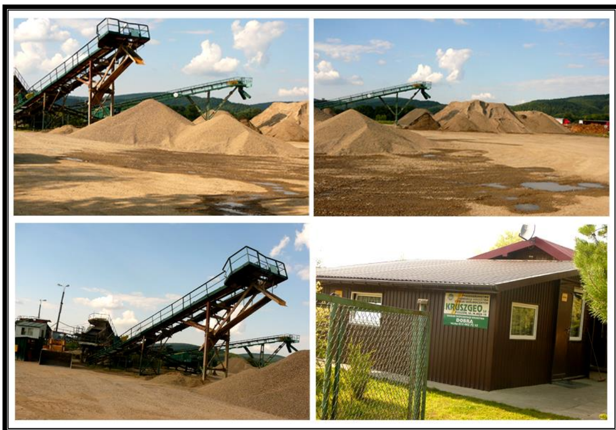
Fot. 3: Istniejący Zakład Przerobu Kruszywa Inwestora.
